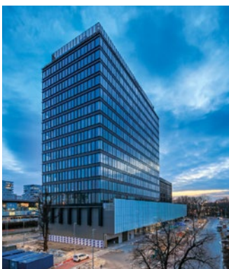
Polyfunkční centrum Einsteinova, Bratislava, Slovensko
